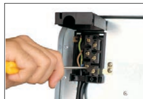
Caja de conexión de fácil acceso. Easily accessible connection box.
